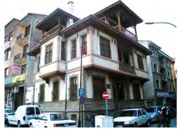
Sonuç olarak incelenen Konya evlerinin inşasında genellikle taş, kerpiç, ahşap, kısmen tuğla ve madenî malzeme kullanılmıştır. Duvar örgülerinde izbe ve zemin katlarda Sille, Gödene veya Yazır taşı kullanılırken üst katlarda kerpiç kullanılmıştır. Bazı baca ve kirpi saçaklarda tuğla kullanıldığı görülür. Kiremit ise üst örtüde alaturka veya Marsilya tipi kiremitler tercih edilmiştir.
